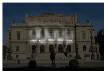
mise en valeur des balcons
